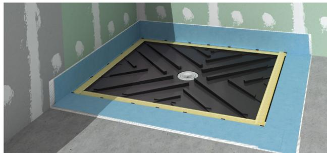
6. Imperméabilisez le périmètre du plateau avec lamiband 200 et mortier colle de type C2.
