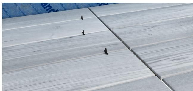
8. Vérifiez que les carreaux de céramique reposent bien sur les nervures de la base, en occupant tout l'espace entre les butées du receveur de douche. Laissez des joints ouverts de 3-4 mm.
